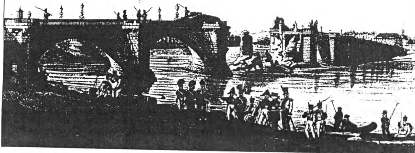
Die Augustusbrücke nach der Sprengung am 19. März 1813 bei der Ankunft des russischen Parlamentärs
